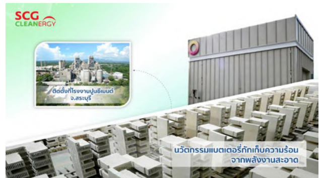
แบตเตอรี่กักเก็บพลังงานความร้อนจากพลังงานสะอาด Rondo Heat Battery ที่โรงงานปูนซีเมนต์ไทย จังหวัดสระบุรี
