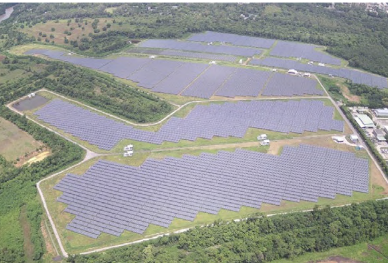
ฟาร์มพลังงานแสงอาทิตย์ (Solar Farm) บริษัทปูนซีเมนต์ไทย (แ่งค้อย) จำกัด
